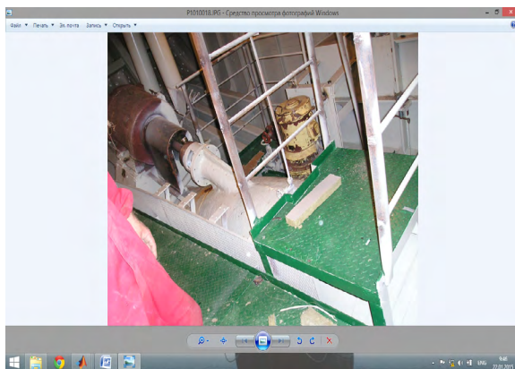
Рис. 2. Установка асинхронного двигателя подруливающего устройства на буксире «Челси-4»
