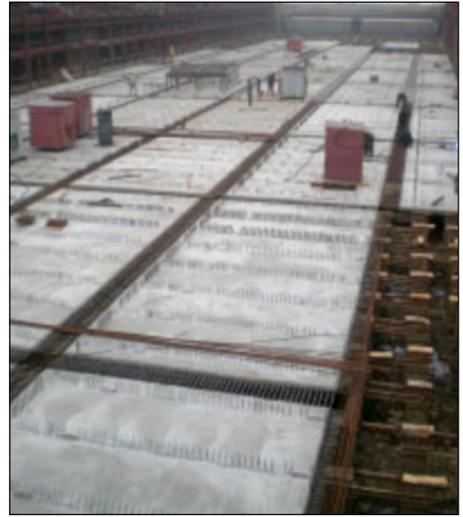
Рис. 3. Формирование дна железобетонного понтона на стапеле большой док-камеры
